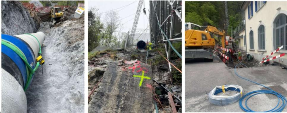
Und präsentiert das Beton-Gussrohr, welches oben herab hängend über die Fluh gebaut wird. Die alten Betonsockel werden neu fundamentiert, die Rohre ineinander hineingesteckt und verriegelt, bis sie schlussendlich ans Werk geführt werden. Die Vorarbeiten sind auf dem Bild rechts ersichtlich, inklusive Felsanker.
